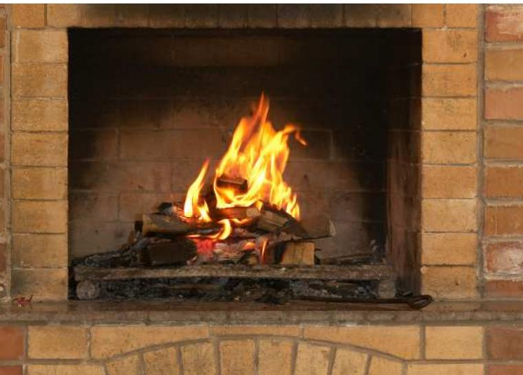
Keine offenen Kamine im Sinne der 1. BlmSchV sind solche Feuerstätten, die zwar in der Bauart dem klassischen offenen Kamin entsprechen, die aber mit einer selbstschließenden Feuerraumtür ausgestattet sind. (Dazu gehören Kaminöfen der Bauart 1 entsprechend DIN 18891.) Diese Feuerstätten unterliegen keiner zeitlichen Betriebsbeschränkung. Im Zweifelsfall müssen die örtliche Ordnungsbehörde oder das Schornsteinfegerhandwerk befragt werden.
