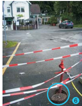
5+6: Hydranten Schützen, Anschluss Standrohre (Vermietung & Abrechnung Schützen)
