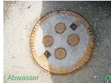
Schmutzwasseranschlüsse (H= Deckel wie Hydrant, nur ohne Kennz.!) NH
