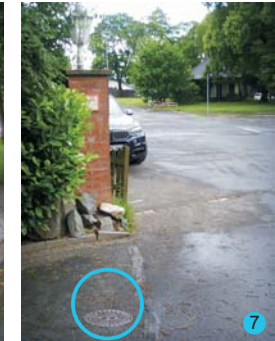
4+7: Hydranten privat, KEIN Trinkwasser, Anschluss Standrohre
