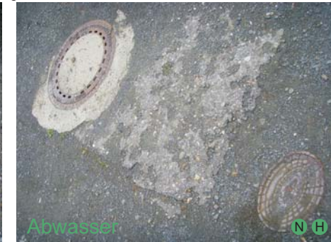
Schmutzwasseranschlüsse (H= Deckel wie Hydrant, nur ohne Kennz.!) NH
