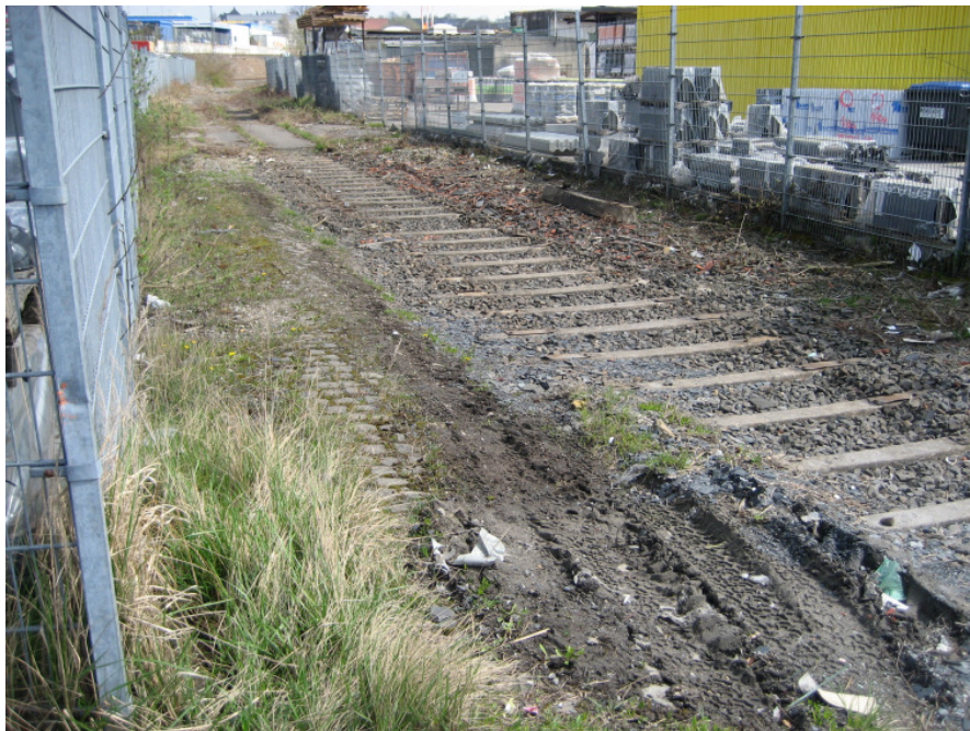
Ehemaliger Gütergleisanschluss nördlich Am Ostbahnhof 5
