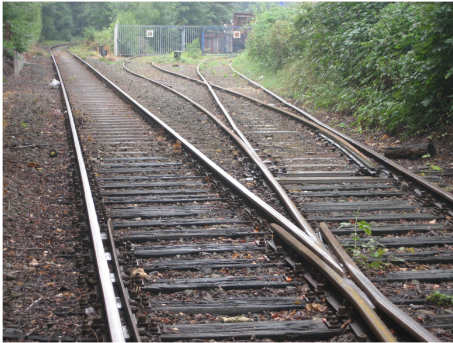
Gütergleisanschluss Lennepers Straße 57*
