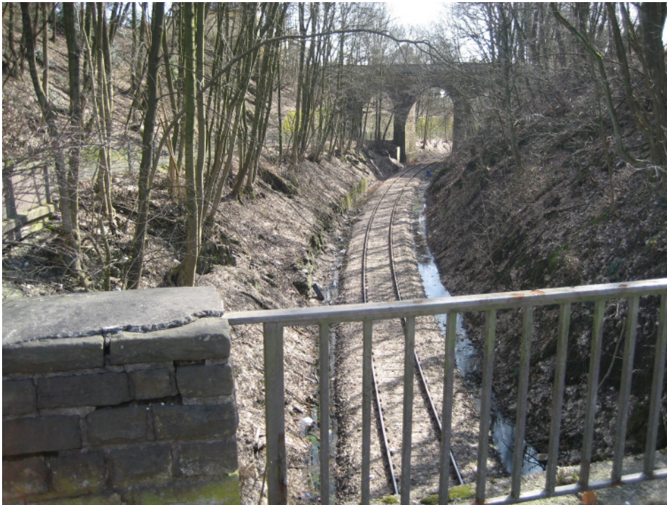
Güterbahntrasse/begehbare und befahrbare Grünstruktur (Blick von Lennep Straße nach Süden mit Intzebrücke)
