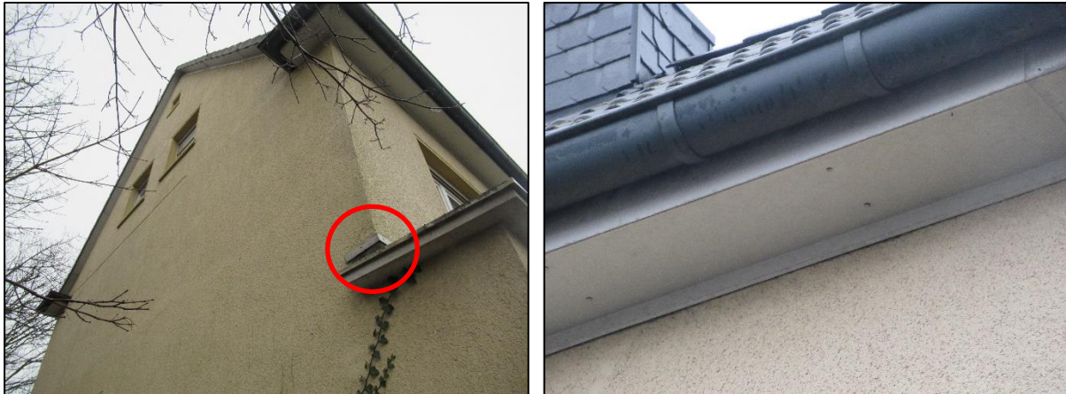
Abbildung 4: Unbewohntes Haus mit Metallverkleidung (rot markiert) / Spalt zwischen Regenrinne und Hauswand
