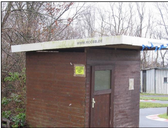
Abbildung 10: Schuppen mit Öffnungen zwischen Wänden und Dach
