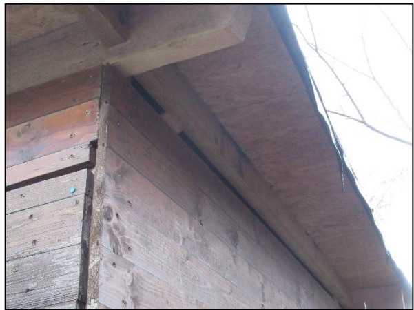
Abbildung 10: Schuppen mit Öffnungen zwischen Wänden und Dach
