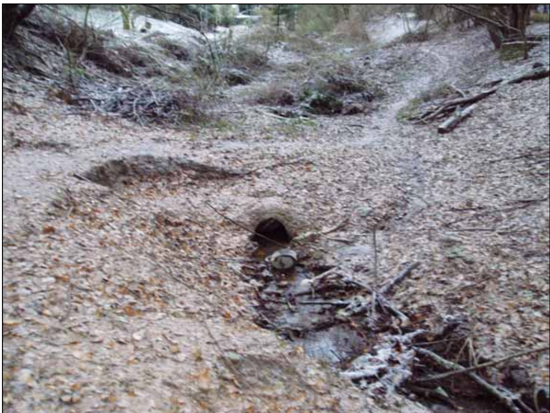
Foto 6: Austritt des Preyersmühlenbach am Ende der Rohrleitung
