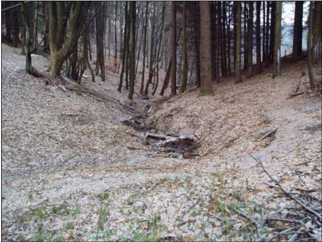
Foto 7: Verlauf des Preyersmühlenbaches unterhalb der Rohrleitung
