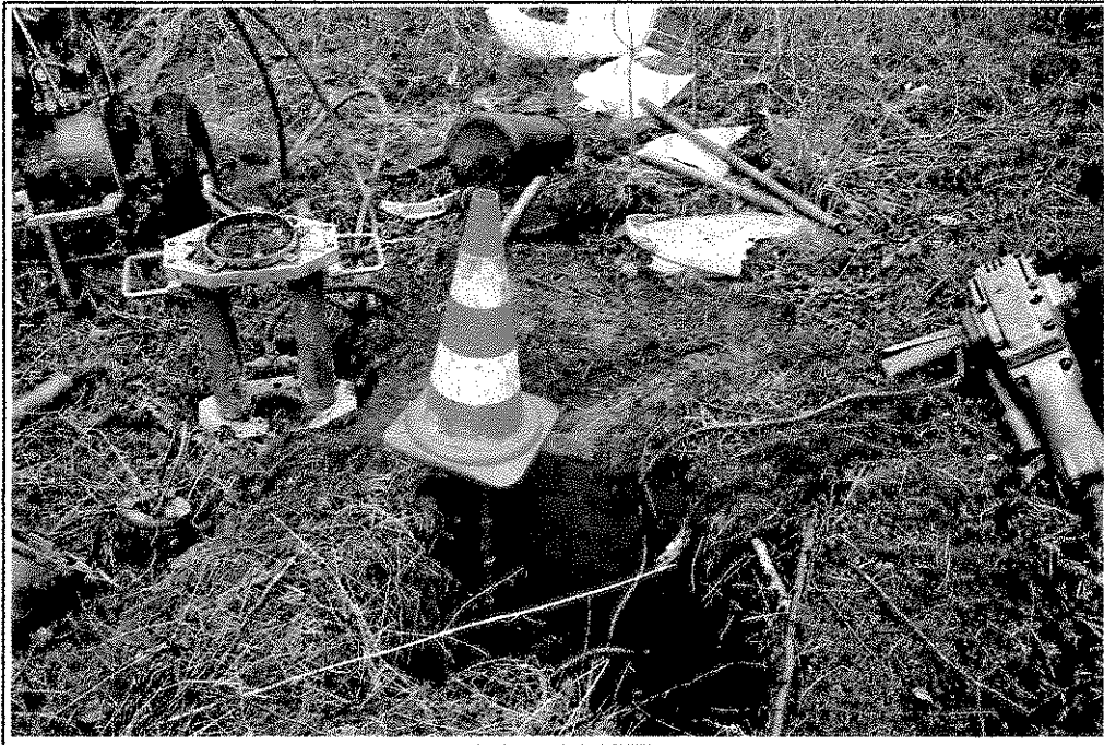
Abb. 5: Blick auf die in der Sickergrube abgeteufte Sondierung RKS 104.
