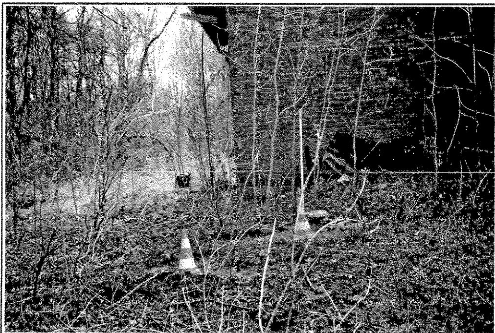
Abb. 2: Blick in südwestliche Richtung auf die durch Warnkegel markierten Ansatzpunkte RKS 102a (rechts) und RKS 102b (links) am ehemaligen Magazin für Farben und Lacke im Bereich einer ehemaligen Sickergrube.
